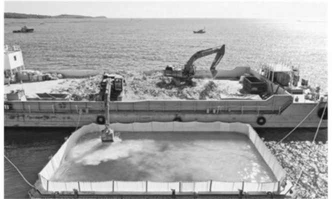
沖縄県名護市辺野古 大浦湾で台船上から石材を投入するパワショベル。石材が投入されるたびに海が白濁 (2/10付しんぶん赤旗電子版より)
