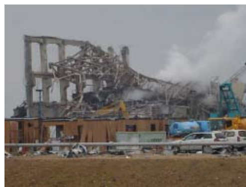
作業員が撮影した原子炉建屋の外観 ＝2011年3月15日撮影（東京 電力提供）
